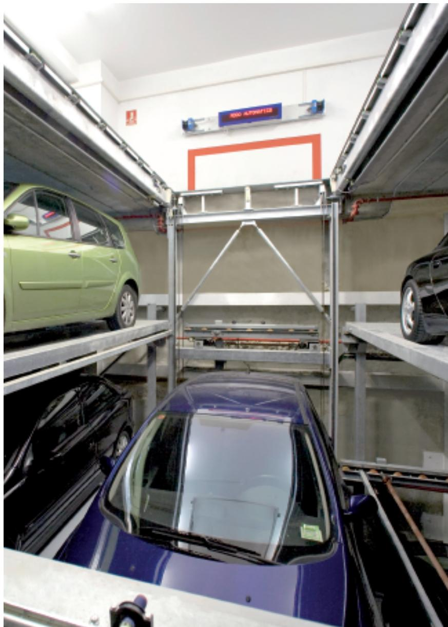
Das automatische Flächensystem nutzt die Grundfläche eines Objekts optimal aus.
